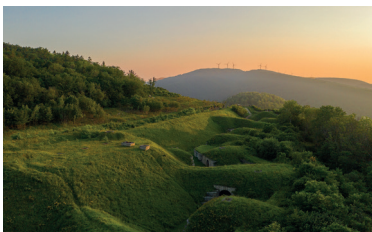
Batterie des Roches
